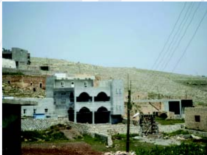
Neues Wohnhaus in Kefnas/Midyat
