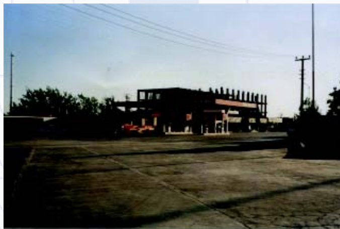
Tankstelle und Hotelrohbau in Viransehir
